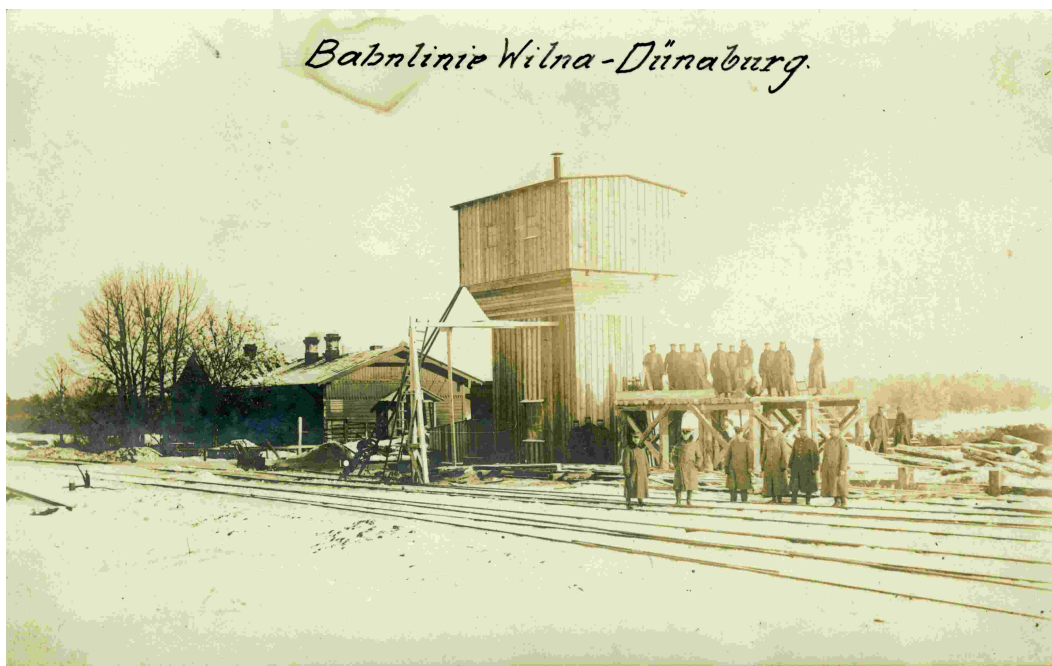
12. attēls. Ūdenstornņa būvniecība Visaginas dzelzceļa stacijā 1915./1916. gada ziemā. Fotografārs nezināms. Toma Altberga kolekcija
